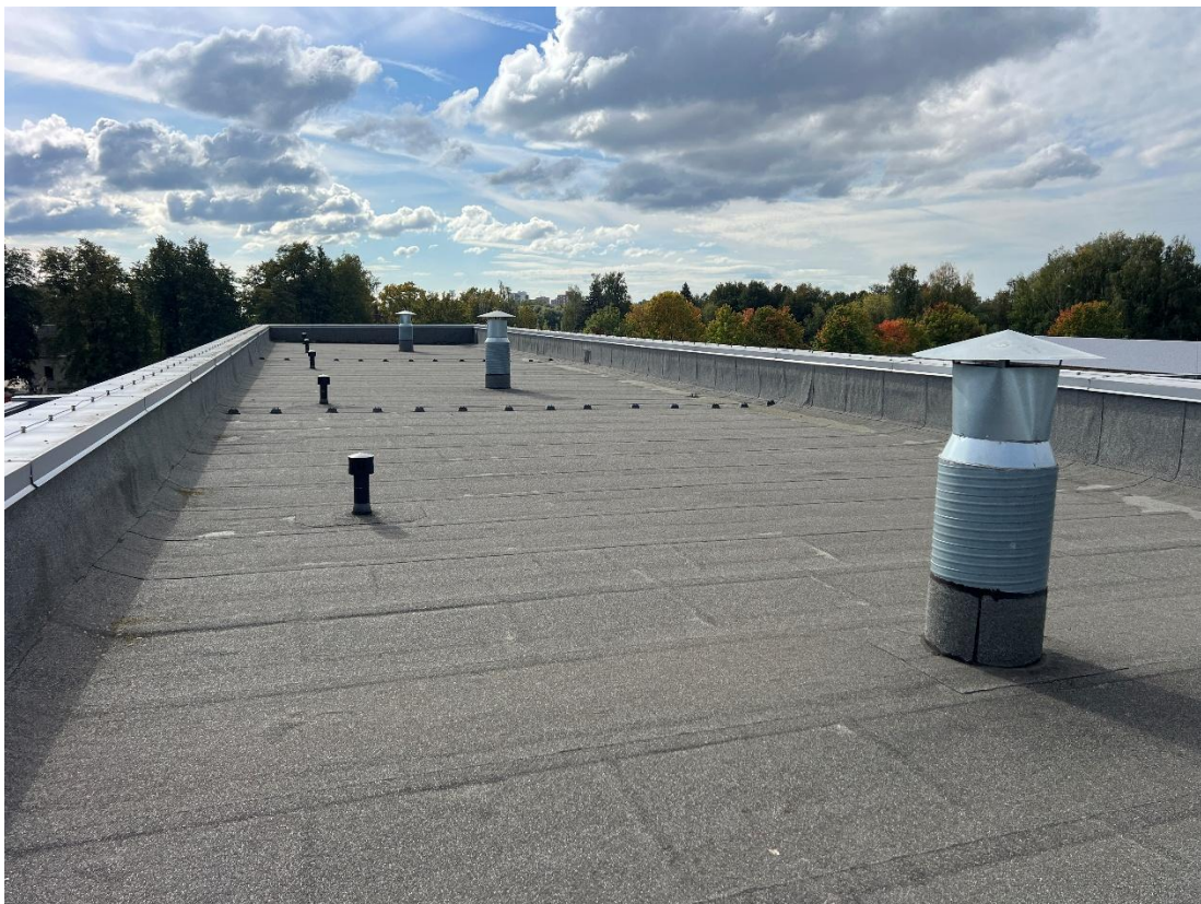
27 pav. Priestato stogo dangos būklės fotofiksacija
