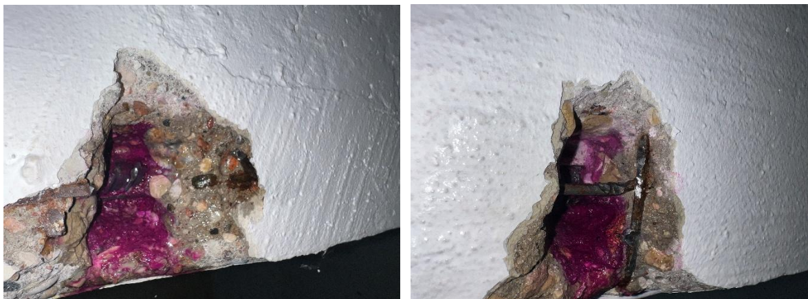
20-21 pav. Nustatytas denginio plokščių betono šarmingumas
