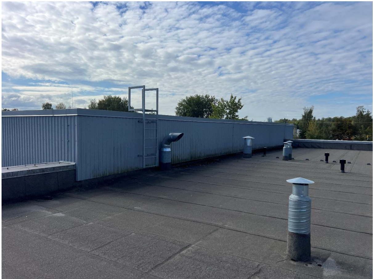
14 pav. Stogo dangos būklės fotografacija
